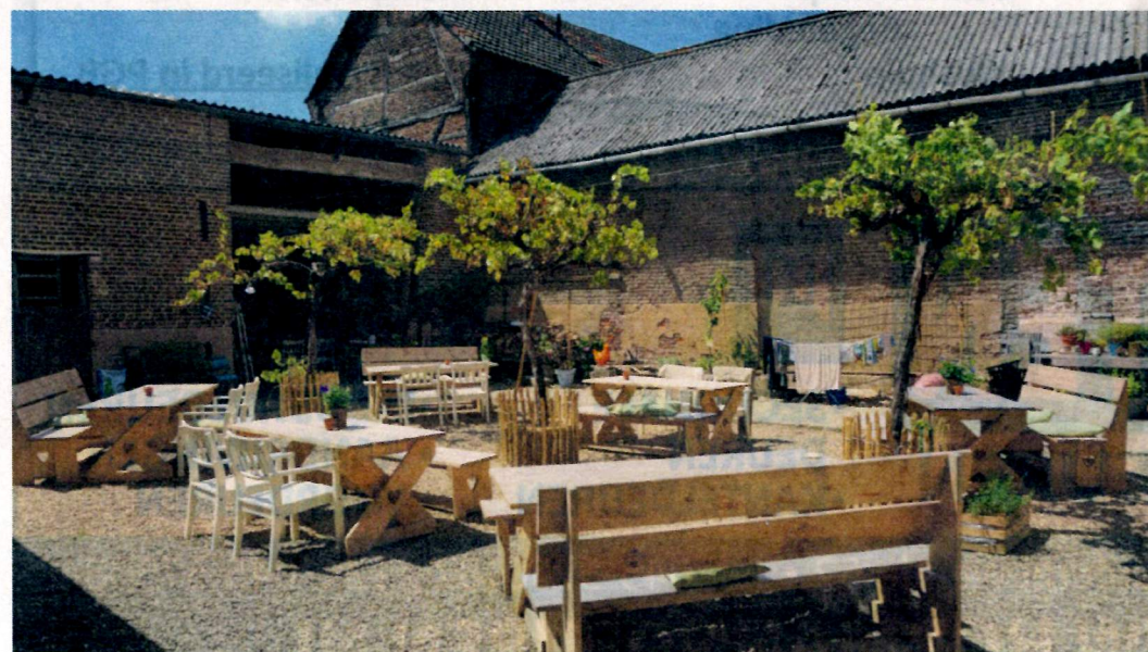
De binnenplaats van Laar 16 na afronding van de restauratie.
